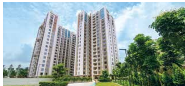
Ozone South EM Bypass
